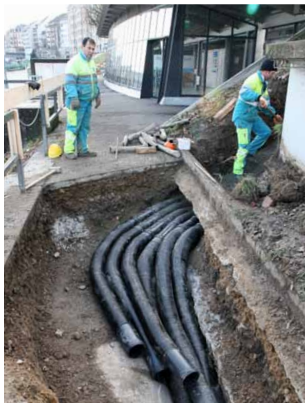
Bauarbeiten am Steiger St. Johann
