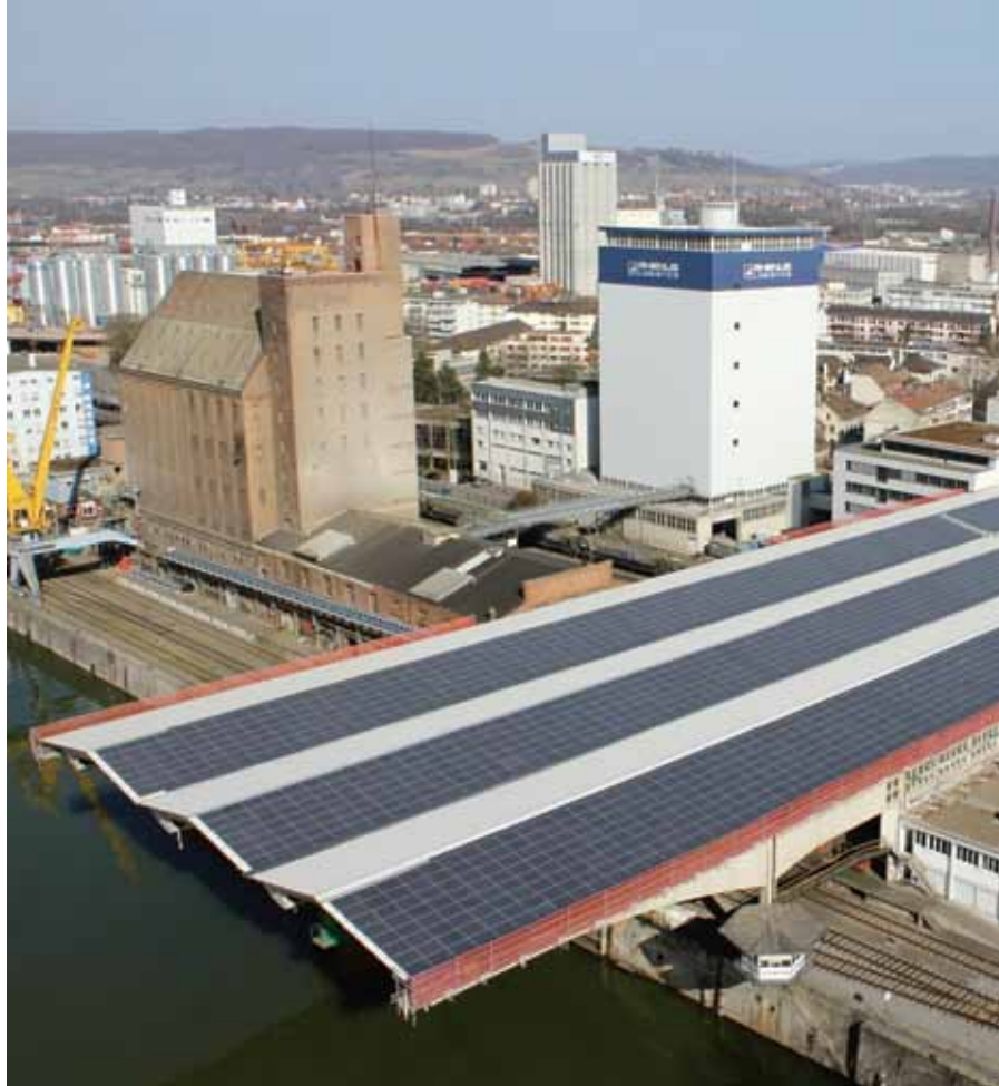
Photovoltaikanlagen auf dem Rhenus-Dach
