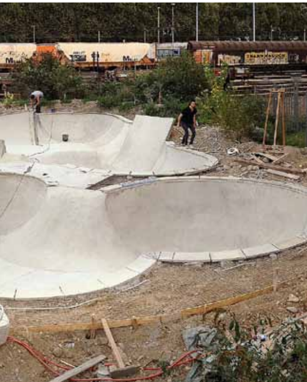
Bau der Skateranlage der «Betonfreunde Basel»
