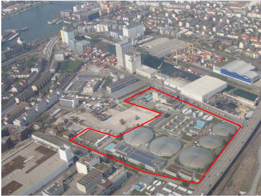
Abb. 1 ARA Basel mit Schlammbehandlung
