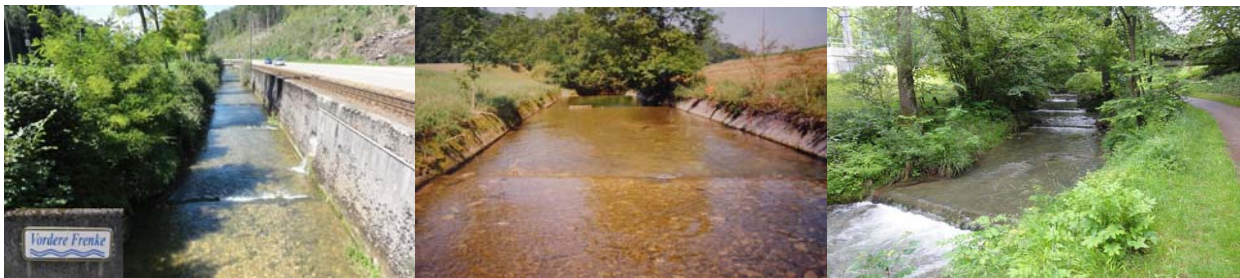
Abbildung 3: Abschnittsweise steile Betonwände, eine grosse Gerinnebreite mit wenig Beschattung und Schwellen prägen das Bild der Vorderen Frenke.
