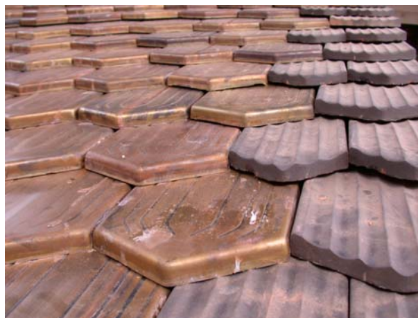
Abb. 8: Aufnahmen des optisch kaum sichtbaren Energieziegels "ATMOVA" von Swissmetall.
