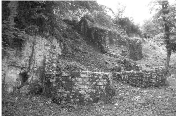
Ruine Pfeffingen. Die Unterburg (Abschnitt 6) ist heute stark überwachsen, die verbliebenen Mauerreste weisen grosse Ausbrüche auf.
