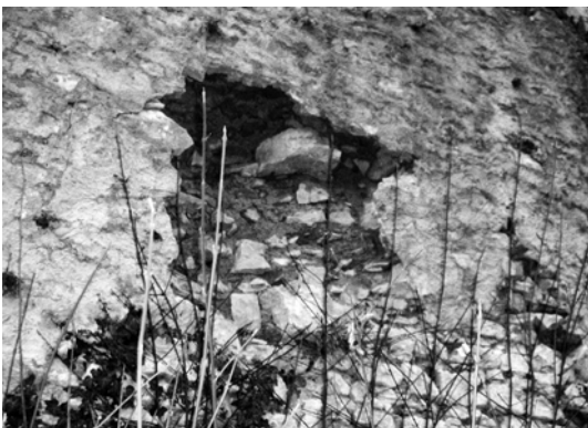
Typische Frosts Schäden auf der Homburg: Der Fuss des Mauermantels wurde durch gefrierendes Wasser abgesprengt. Der dahinter liegende Mauerkern hat sich bereits grossflächig aufgelöst: Es ist nur eine Frage der Zeit, bis die Mauer abstürzt.
