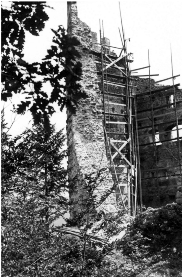
Konservierungsarbeiten auf Schloss Pfeffingen im Jahre 1931, die letzten umfassenden Sanierungsarbeiten auf dem Wahrzeichen des hinteren Birseck.
