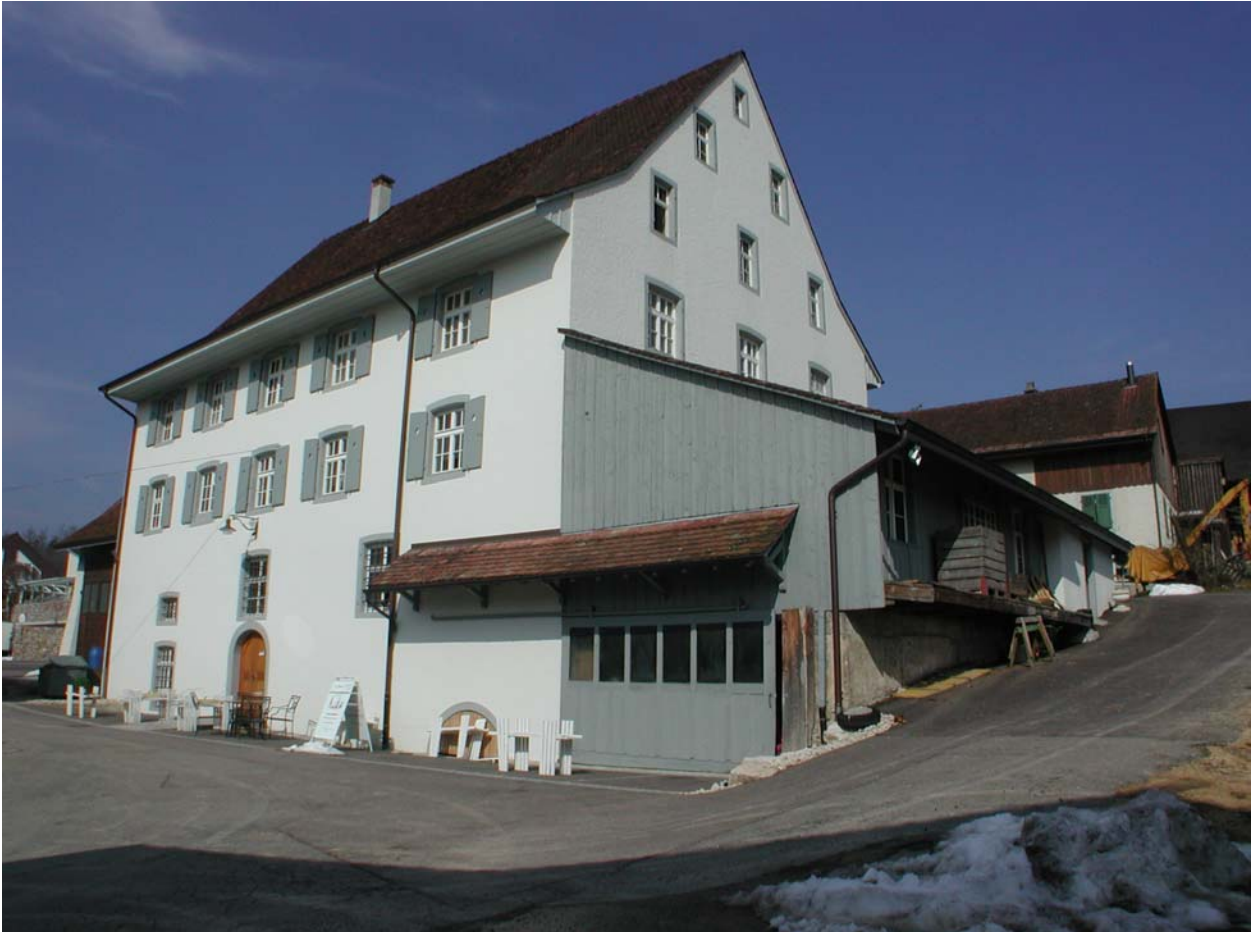
Aussenrenovation der ehem. Getreidemühle in Arisdorf.
