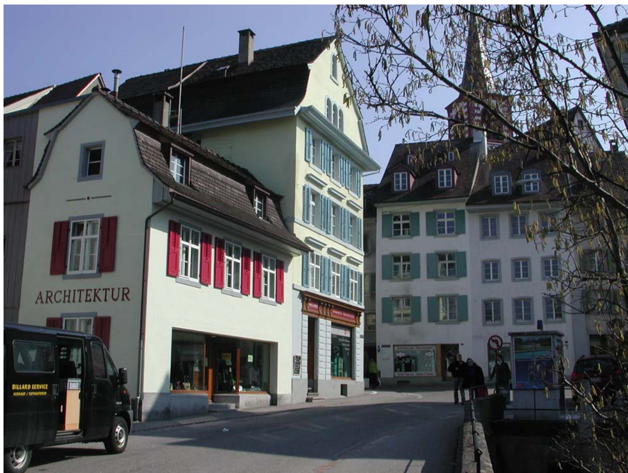
Renovation und Umbau des Stadthauses Rheinstrasse 2 in Liestal.
