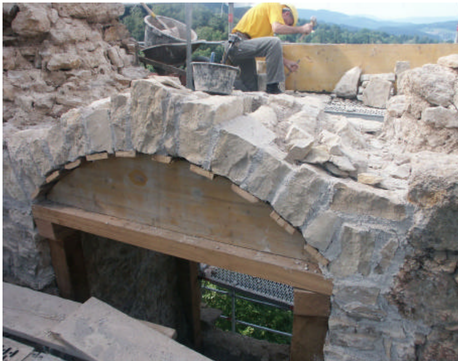
Wiederaufbau der Fenstergewölbe der Mauer Süd.
