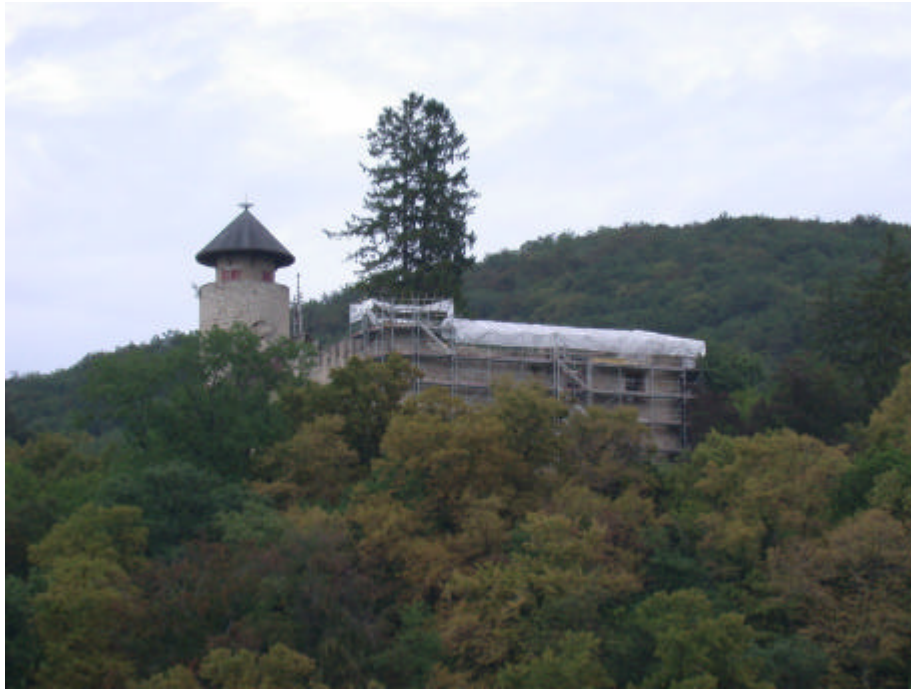
Sommer 2004: Die Südmauer ist eingerüstet.
