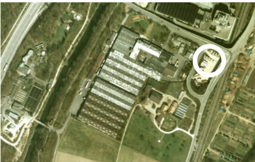
Abb. 18: Lage des Mischwasserbeckens Arlesheim (Bereich Talstrasse/Sundgauerstrasse)
