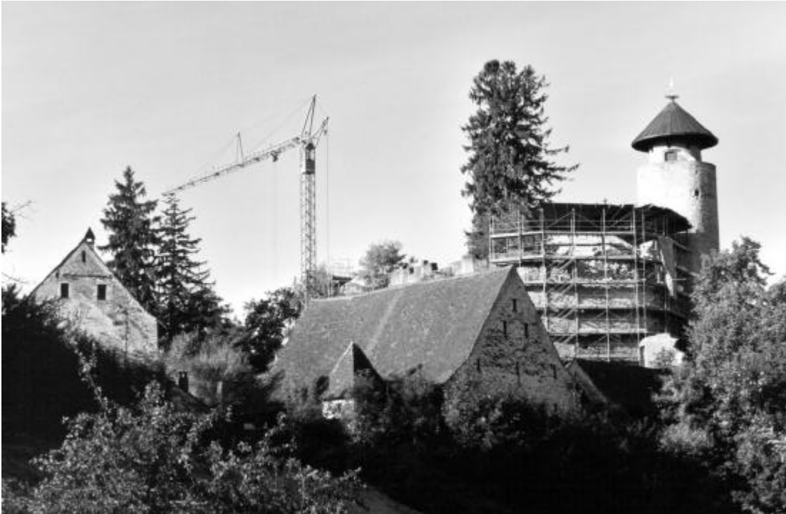
Arlesheim, Schloss Birseck, Schlossgasse 12. Sanierung der Umfassungsmauer, die grossenteils aus der Erbauungszeit des Schlosses stammt (13. Jahrhundert).
