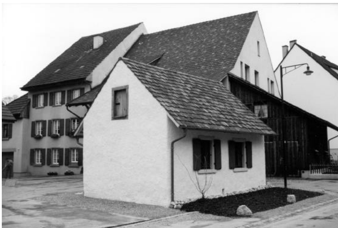
Pratteln, "Buchhüsi" Hauptstrasse 82. Renovation des letzten Waschhauses im Dorfe.
