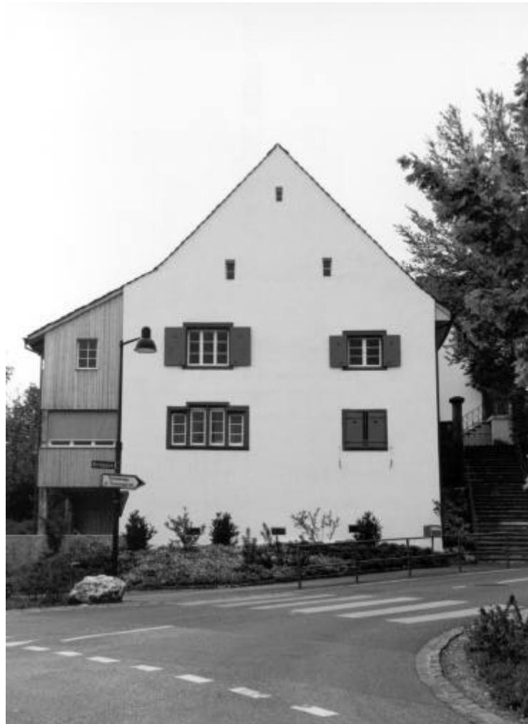
Oberwil, "Härig-Huus", Kirchgasse 5. Renovation und Umbau des spätmittelalterlichen Sigristenhauses.
