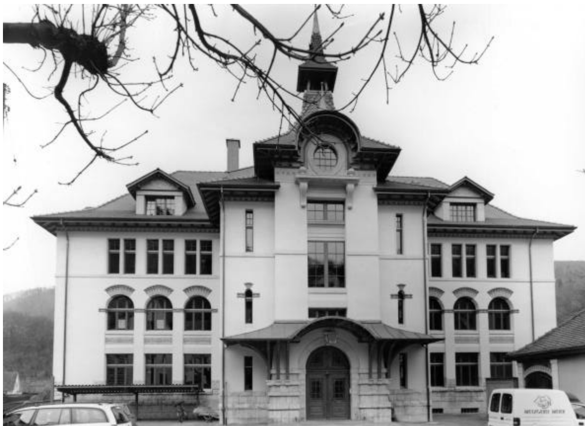
Grellingen, Primarschulhaus, Baslerstrasse 6. Aussenrenovation und Wiederherstellung der ursprünglichen Dekorationsmalerei.
