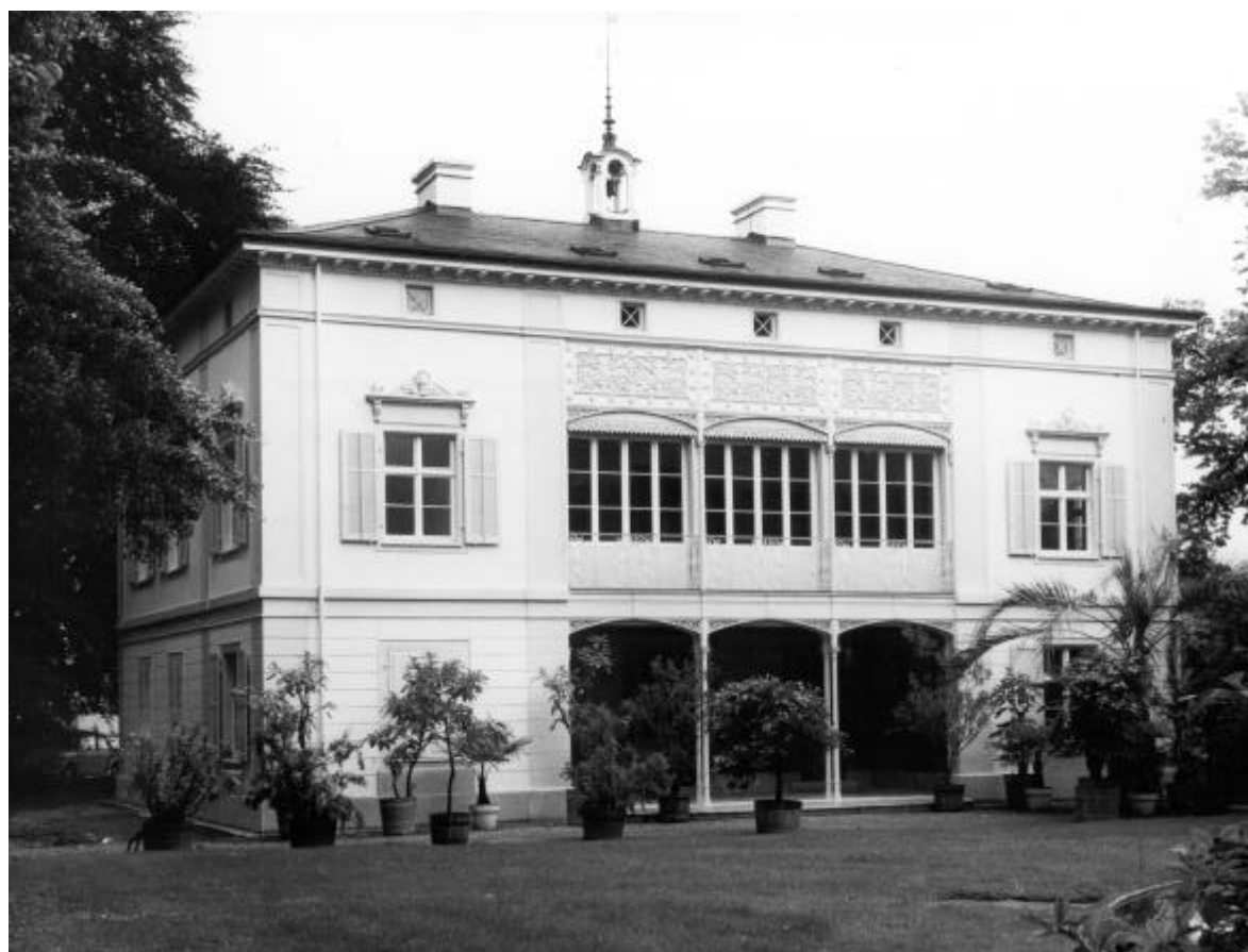
Münchenstein, Villa Merian. Renovation der historischen Innenräume und Sanierung der Büroräume im 1. Obergeschoss.
