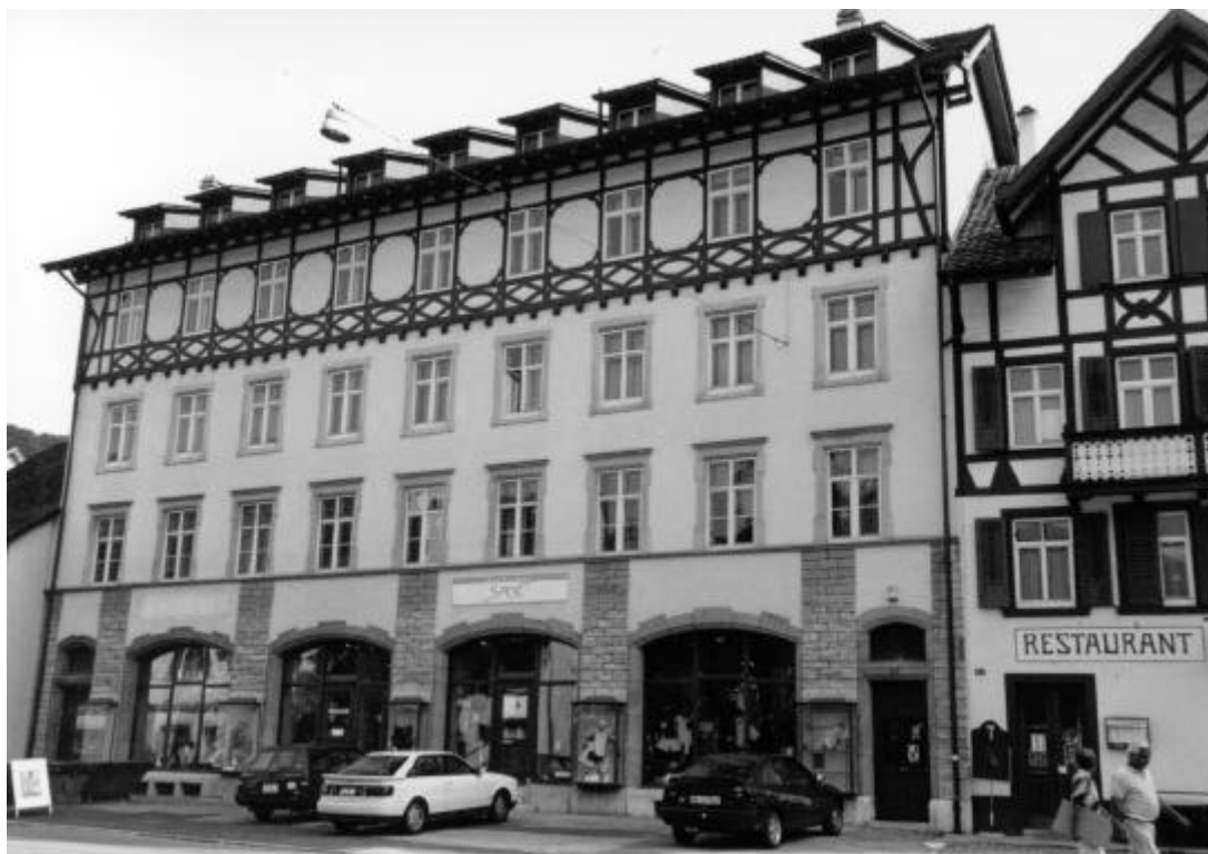
Sissach, "Cheesmeyer", Hauptstrasse 55. Vorbildliche Renovation des 1. Baselbieter Warenhauses und Konservierung der historischen Papiertapeten und Linoleumböden.
